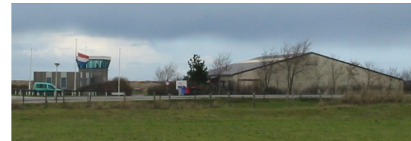
Houtengebouw toren en havenkantoor. Hangaar van plaatstaal. Bij vervanging zal dit aan gepast moeten worden aan een materiaal toepassing met een natuurlijke uitstraling (hout, vegetatie daken o.g.).
